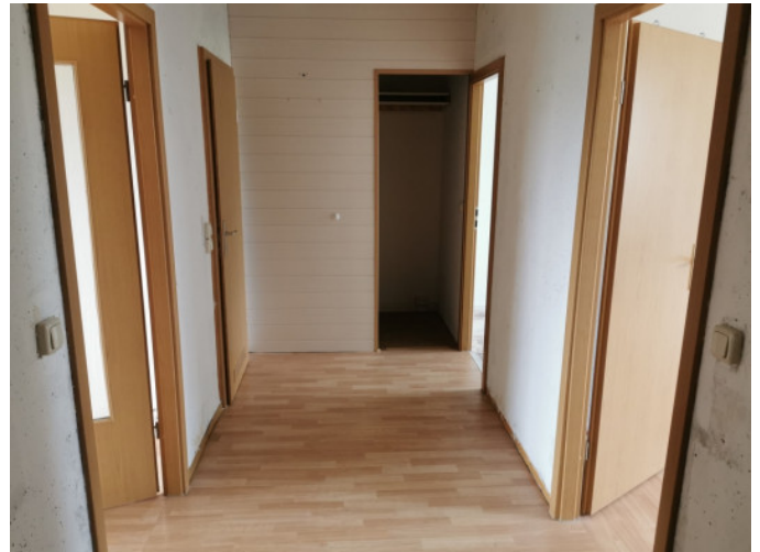
Flur mit Abtrennung
